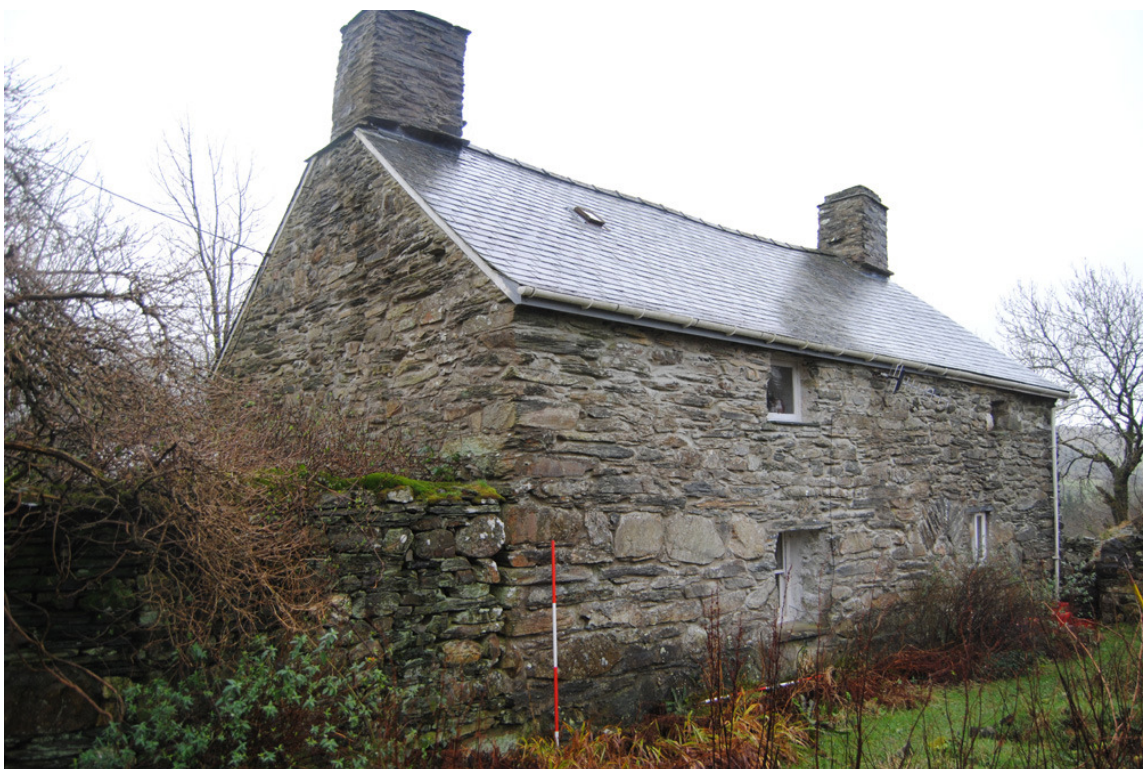
Plate 5: West elevation (oblique).
