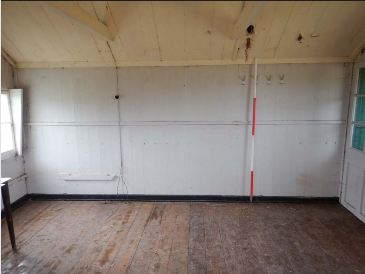
24. N facing elevation looking S.
