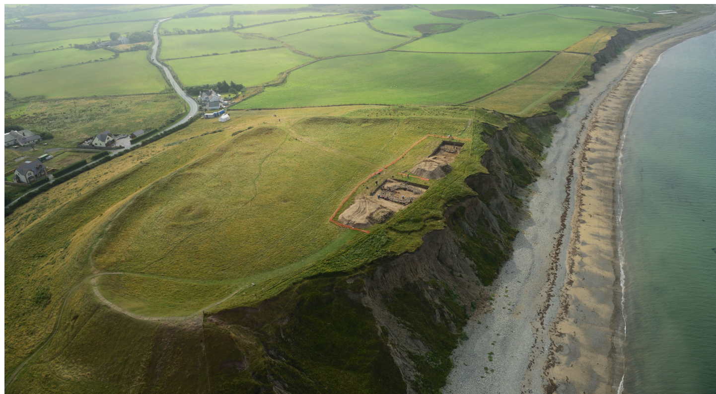
Golygfa o'r awyr yn dangos lleoliad y 2 ffos gloddio yn agos at ymyl bryngaer Dinas Dinlle sy'n erydu yng Ngwynedd. Aerial view showing the location of the 2 excavation trenches close to the eroding edge of Dinas Dinlle hillfort, Gwynedd.
